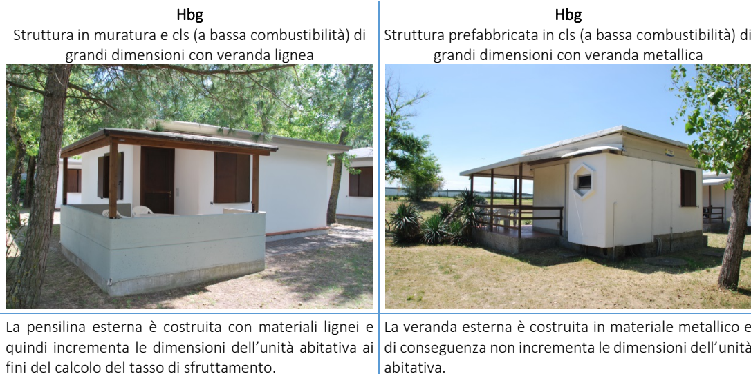
Figura 2.19 – Unità abitative fisse a bassa combustibilità di grandi dimensioni
