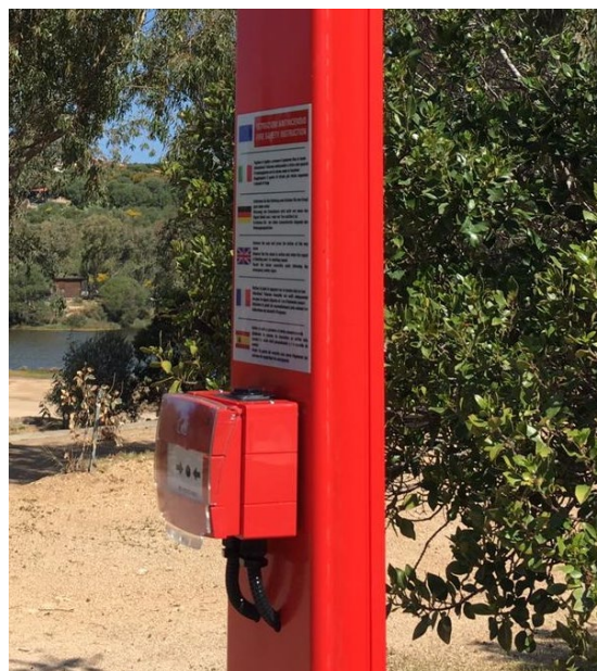
Esempio di pulsante per la segnalazione di un incendio (segnalatore o punto di segnalazione manuale)
