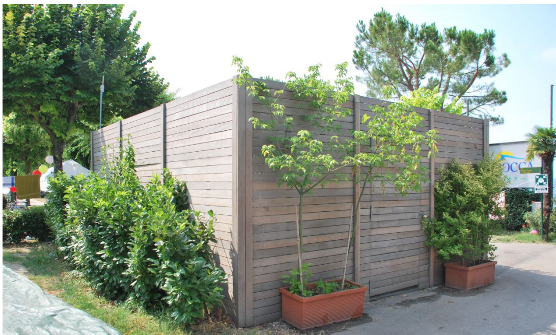
Figura 2.26 - Esempio di area di stoccaggio occultata
